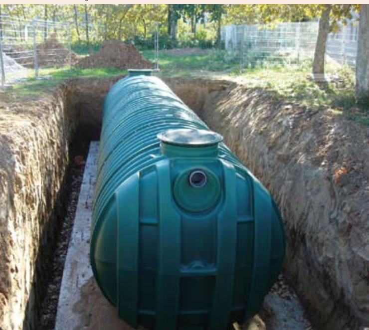
Octubre 2009. Dipòsit de polièster reforçat localitzat al costat del magatzem municipal.
