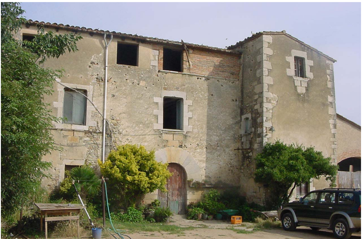
2.- CAN GRUART Entrada i torre, façana Sud-Est
