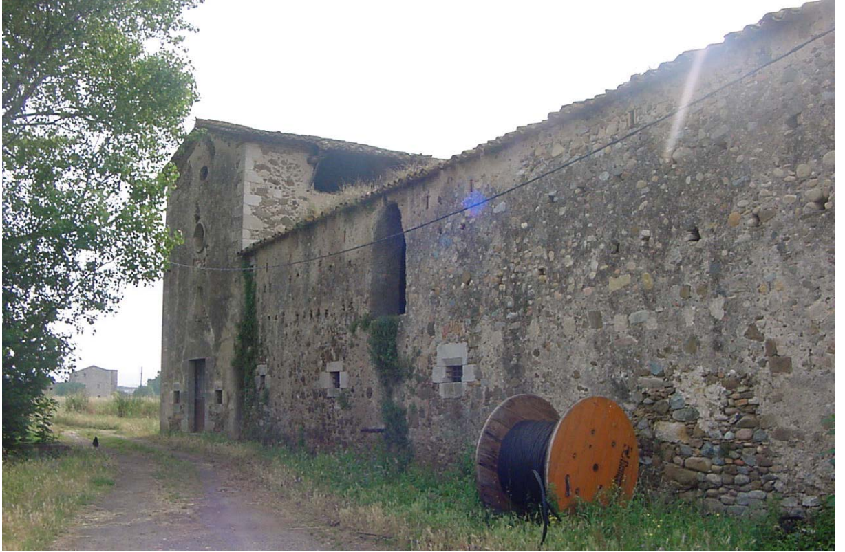
5.- CAN PERE MÀRTIR Façana Nord-Oest Amb cos Nord-Oest i capella de Sant Pere
