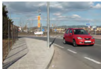
Obres a la carretera Santa Coloma.
