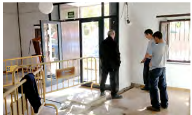
Els treballs de reforma a ple rendiment.
