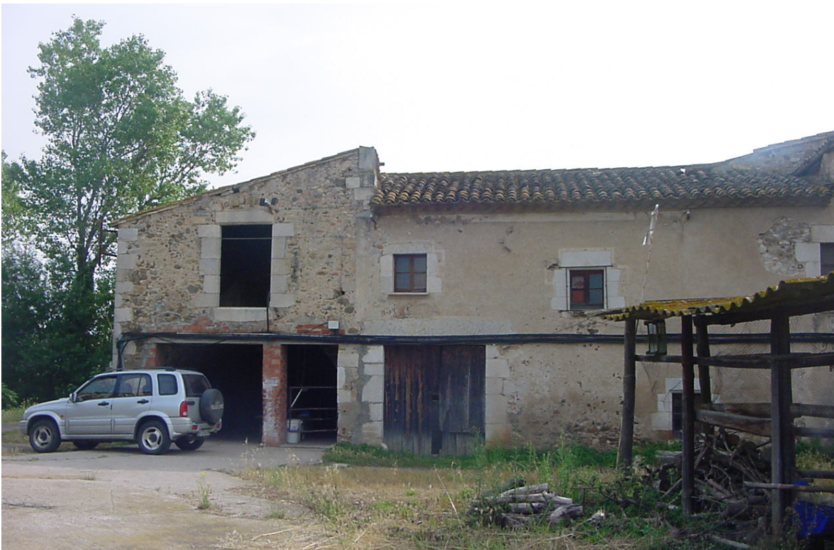
3.- CAN PERE MÀRTIR Façana principal (sud-oest). A l'esquerra: testa del cos nord-oest. A la dreta: cos que relliga la masia original i tanca el pati, originàriament obert.
