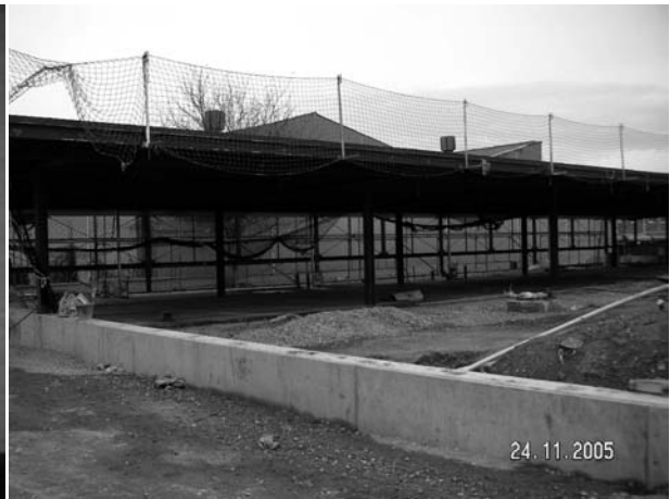
Estat de les obres de la llar d'infants Municipal, a finals de novembre.
