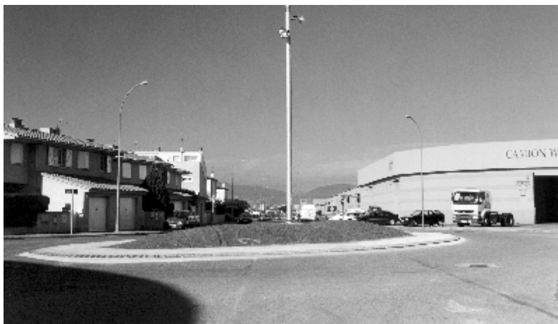
L'el·lipse situada al polígon industrial a l'encreuament dels carrers Mosquerols i Raset.
