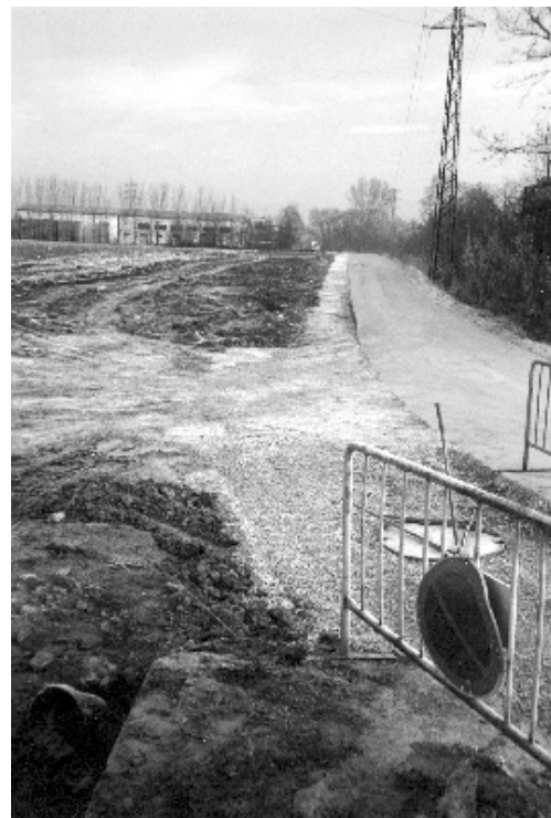
Obres del col·lector de sanejament.
