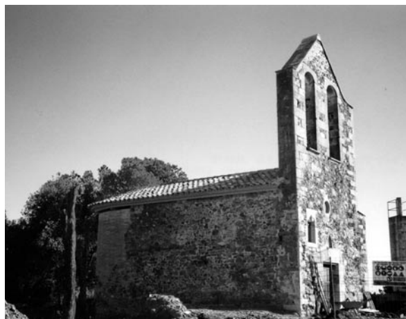
L'Ermita de Sant Roc, pràcticament acabada, només falta posar-hi la porta d'entrada.
