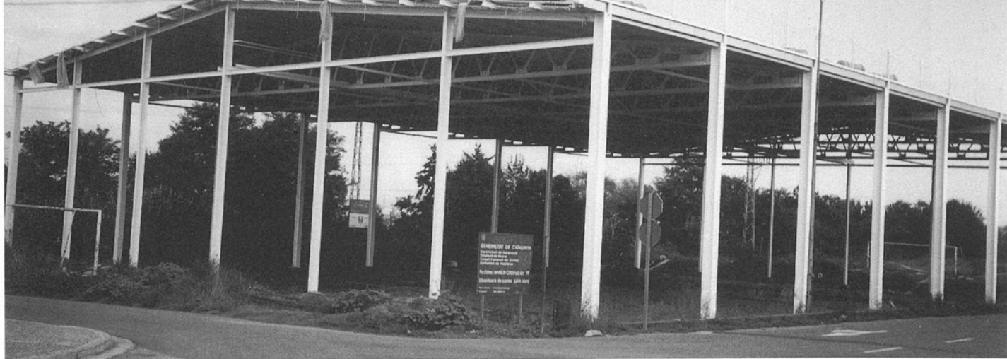
Imatge recent del Cobert Polivalent amb Pista Poliesportiva.
