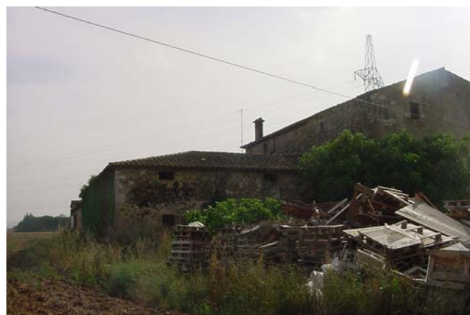
7.- Façana sud-oest. Cossos envoltants del pati.
