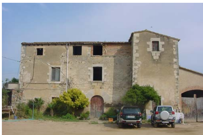
1.- Façana principal, cara sud-est.
