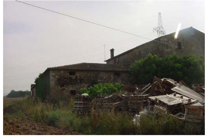
7.- Façana sud-oest. Cossos envolvents del pati.
