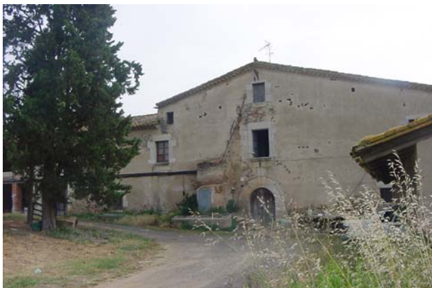
2.- CAN PERE MÀRTIR Façana principal (sud-oest) A la dreta, cobert prescindible.
