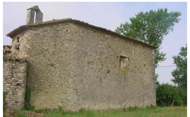
8.- CAN PERE MÀRTIR Façana nord-est.
