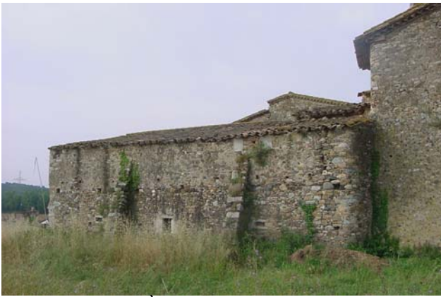
9.- CAN PERE MÀRTIR Façana nord-est.
