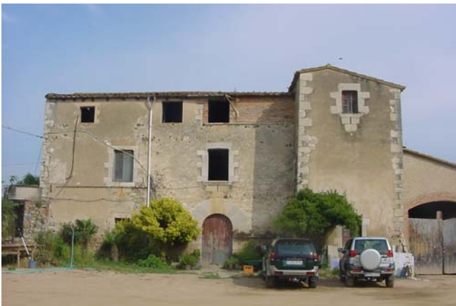
1.- Façana principal, cara sud-est.
