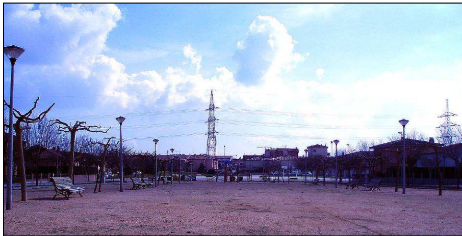
Vista de les línies elèctriques des de Plaça Catalunya
