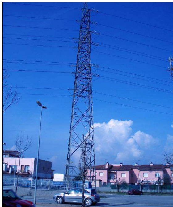
Vista de les línies elèctriques des de Plaça Catalunya
